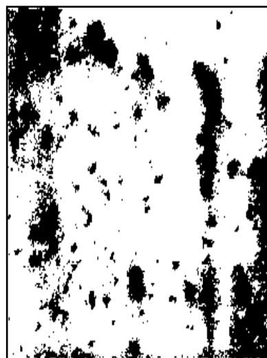
Рисунок А.21 – Коррозия металла – балл К4
