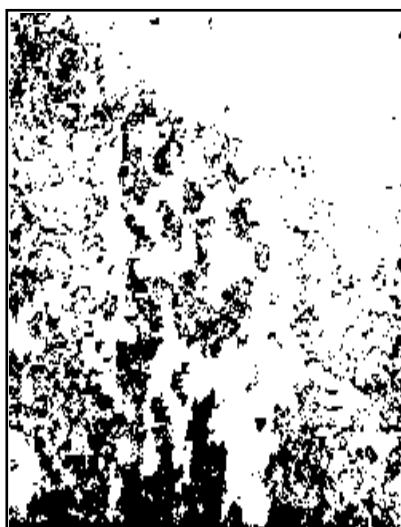
Рисунок А.22 – Коррозия металла – балл К5
